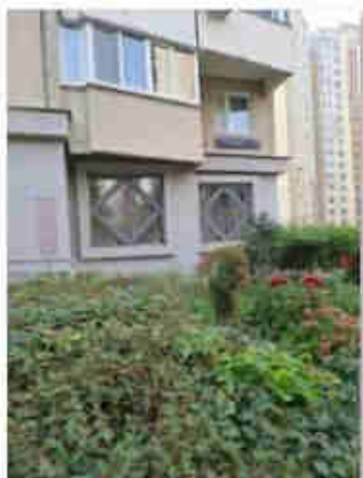
Вид здания снаружи (2)
