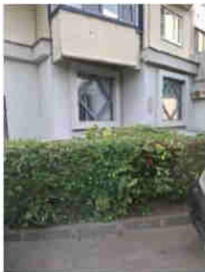
Вид здания снаружи (1)
