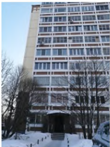
Фото 1. Внешний вид здания
